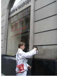
( شكل رقم ٥ ) توضيح دهان النانو على الحجر بالرش .
