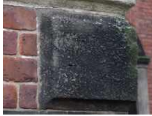
( شكل رقم ٤ ) على اليمين توضيح الحجر و هو معالج بطلاء النانو حجر و على اليسار الحجر بدون معالجة .
