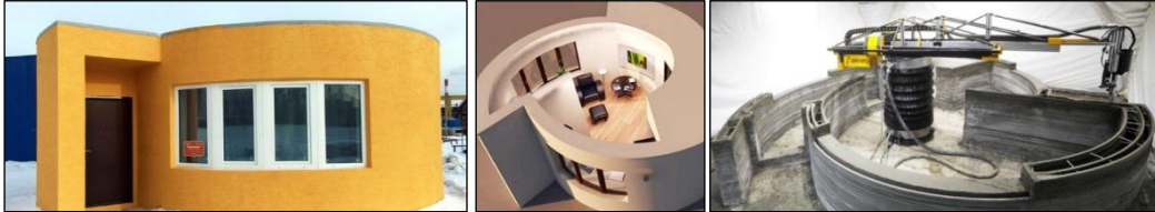
شكل (٣١) الشكل يوضح الوحدة السكنية اثناء الطباعة من الخرسانة
