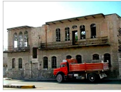
لوحة : 4، بيت النابلسي قبل الترميم ، المصدر بلدية اربد
