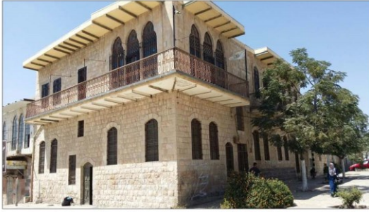
لوحة : 5، بيت النابلسي بعد الترميم
