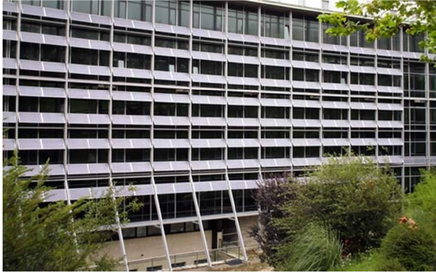
شكل (٧) استخدام نظام الطاقة الكهروضوئية في مبنى كلية الهندسة بجامعة كانتابريا في إسبانيا.
