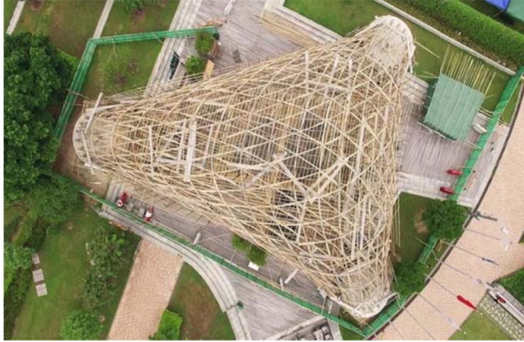
شكل (١١) تم بناء ZCB Bamboo Pavilion الذي تبلغ مساحته ٣٥٠ مترًا مربعًا تقريبًا باستخدام تقنيات السقالات المصنوعة من الخيزران الكانتونني وصنعت من ٤٧٥ عمودًا كبيرًا
