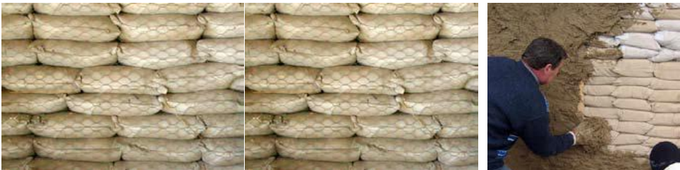
شكل (١٥) صورة توضيحية لطريقة تثبيت الشبك الممدد وتطبيق طبقة
