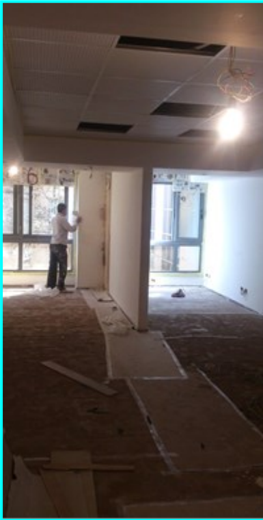
شكل (٢٨) اعمال الاسقف المعلقة (جيبسيوم بورد) في منطقة الاستقبال اثناء عمله التشطيب و استخدام المناسب المختلفه
