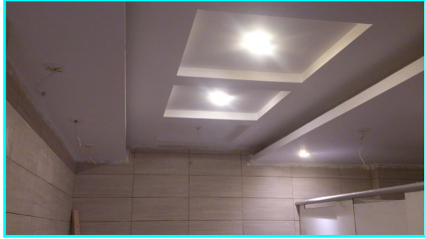
(شكل ٣٠) اعمال الاسقف المعلقه (جيبسيوم بورد) اثناء
