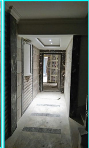
شكل (٢٩) مدخل الشركه واستخدام الرخام في الارضيه والحوائط
